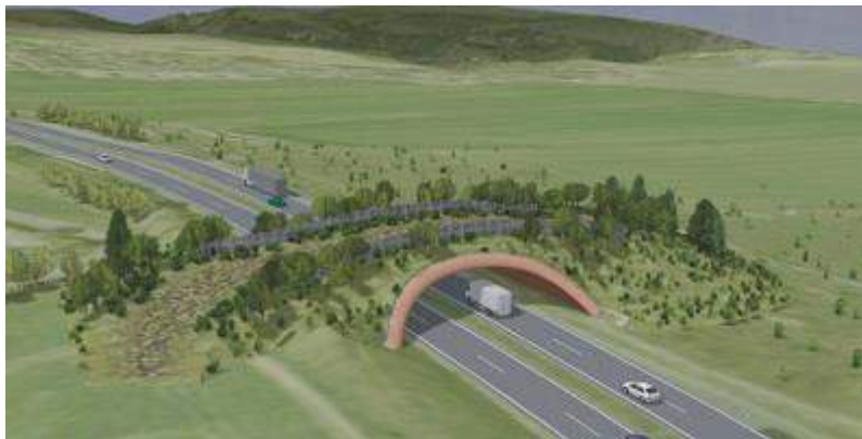
Obr. 7: Defragmentácia ekosystému pri výstavbe cestnej dopravnej infraštruktúry 67
